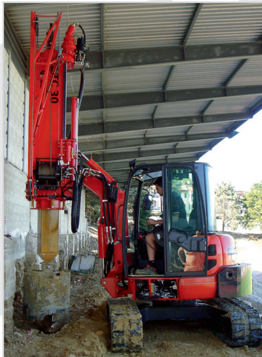
Serie di pali \varnothing 800mm sotto ingombro di 4 metri Working height: less than 4 meters
